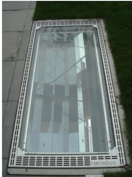
Daylight Shaft nach Sanierung: Boden betoniert
