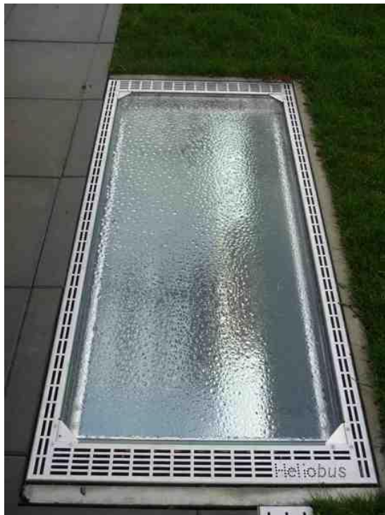
Heliobus daylight shaft avec condensat
