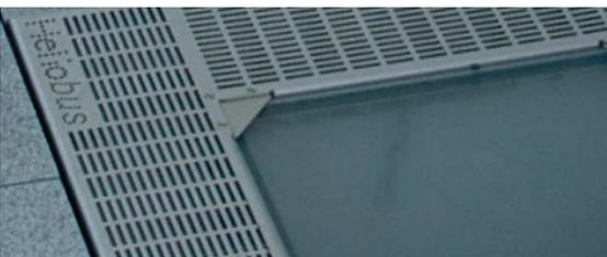
Lichtdurchlässige Rutschhemmung, Verbundsicherheitsglas mit vollflächig rauer Oberfläche. Rutschwiderstand BFU geprüft: GS3, DIN 51130: R12.
