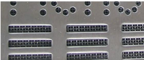
Lüftungsöffnung wird zusätzlich mit Insektengitter 1 mm Maschenweite abgedeckt, hält grössere Insekten fern. Der Lüftungsquerschnitt wird dadurch verringert.
