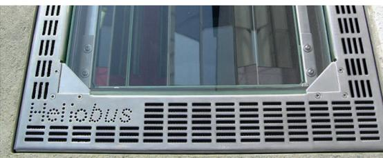
Schachtabdeckungsrahmen in Chromstahl, Oberfläche geschliffen.
