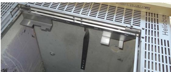
Heliobus® Schachtabdeckung wird mittels Streben an die Schachtwand angeschraubt somit und gegen Abheben von aussen gesichert.
