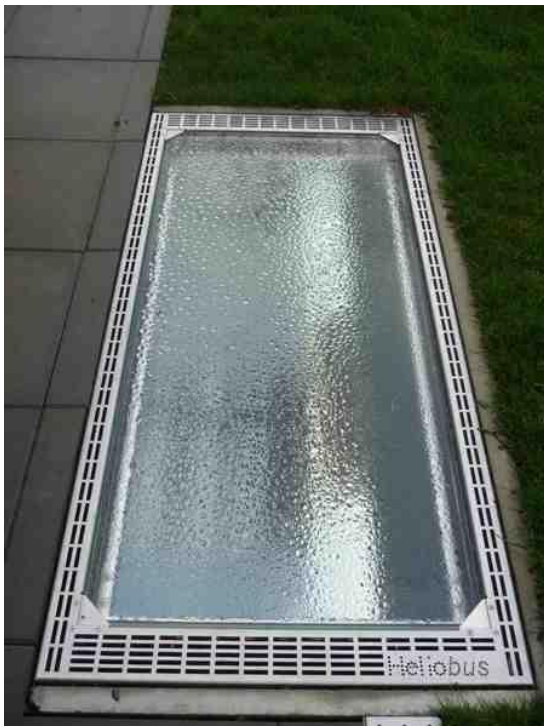
Heliobus daylight shaft mit Kondensat
